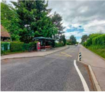
Exemple d'un arrêt de bus bloquant
